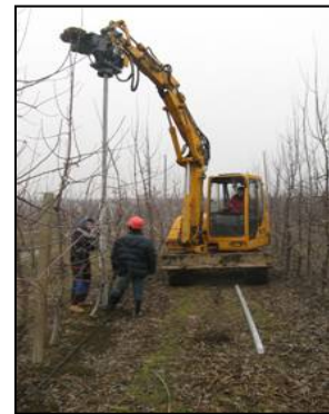
Postavljanje stubova kao noseće konstrukcije za protivgradnu mrežu u starim zasadima jabuke utiskivanjem posebnom mašinom (foto: D. Radivojević).
